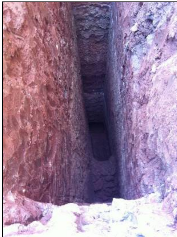
Fotografia 6: Finalització del sondeig de l'extrem SE del solar amb la mina al fons.
