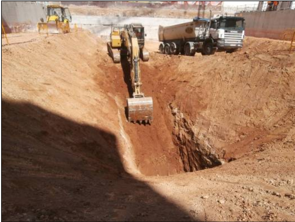
Fotografia 15: Adequació del terreny amb una rampa per accedir a la mina.
