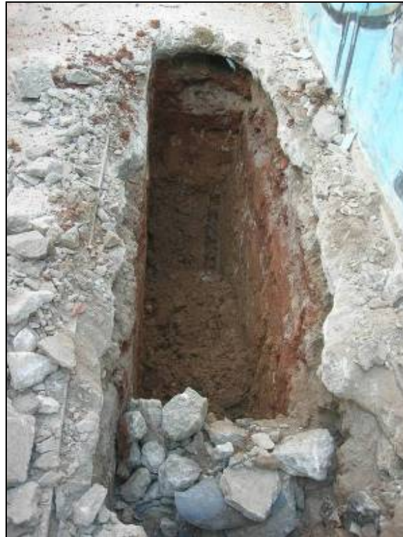
Fotografia 3: Procés d'excavació a l'extrem NO.
