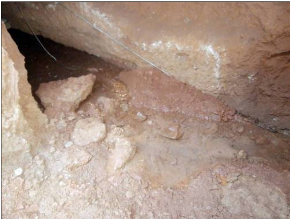
Fotografia 22: Entrada a la galeria on es veu l'aigua circulant de NO vers SE.
