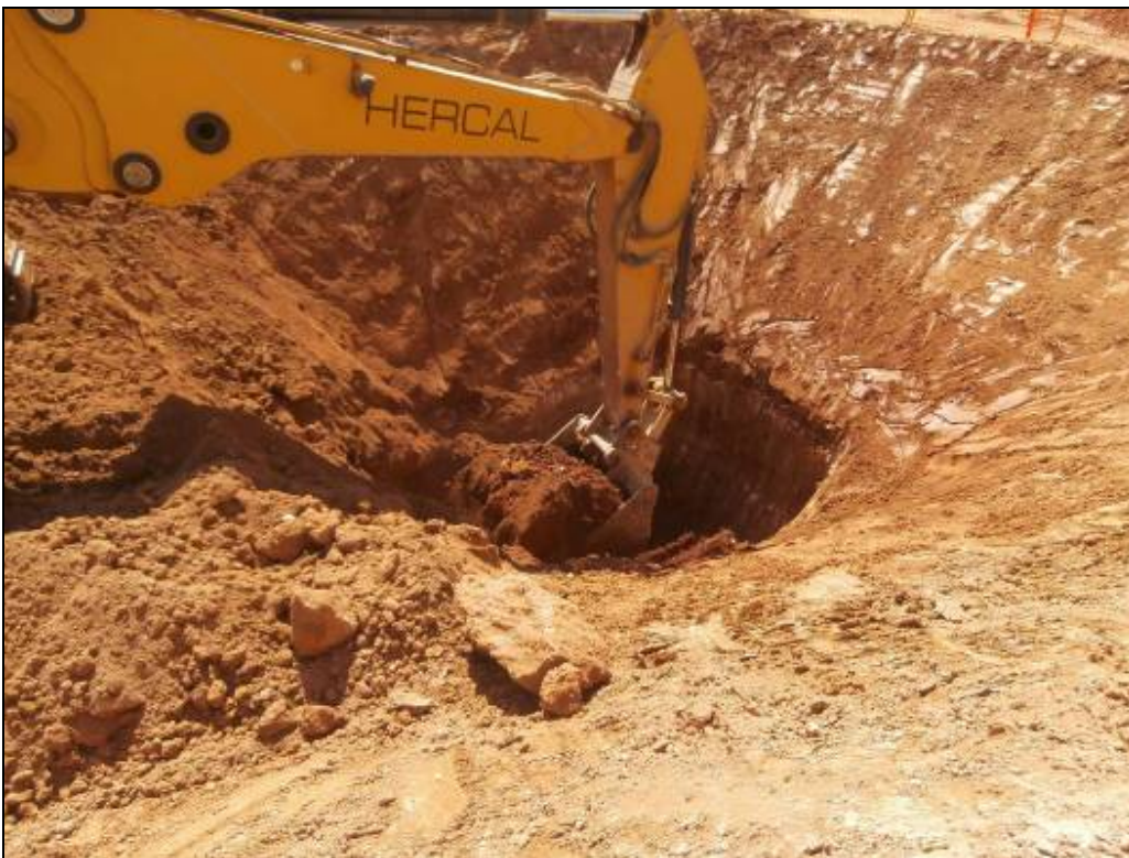
Fotografia 12: Excavació en el punt de pas de la mina.
