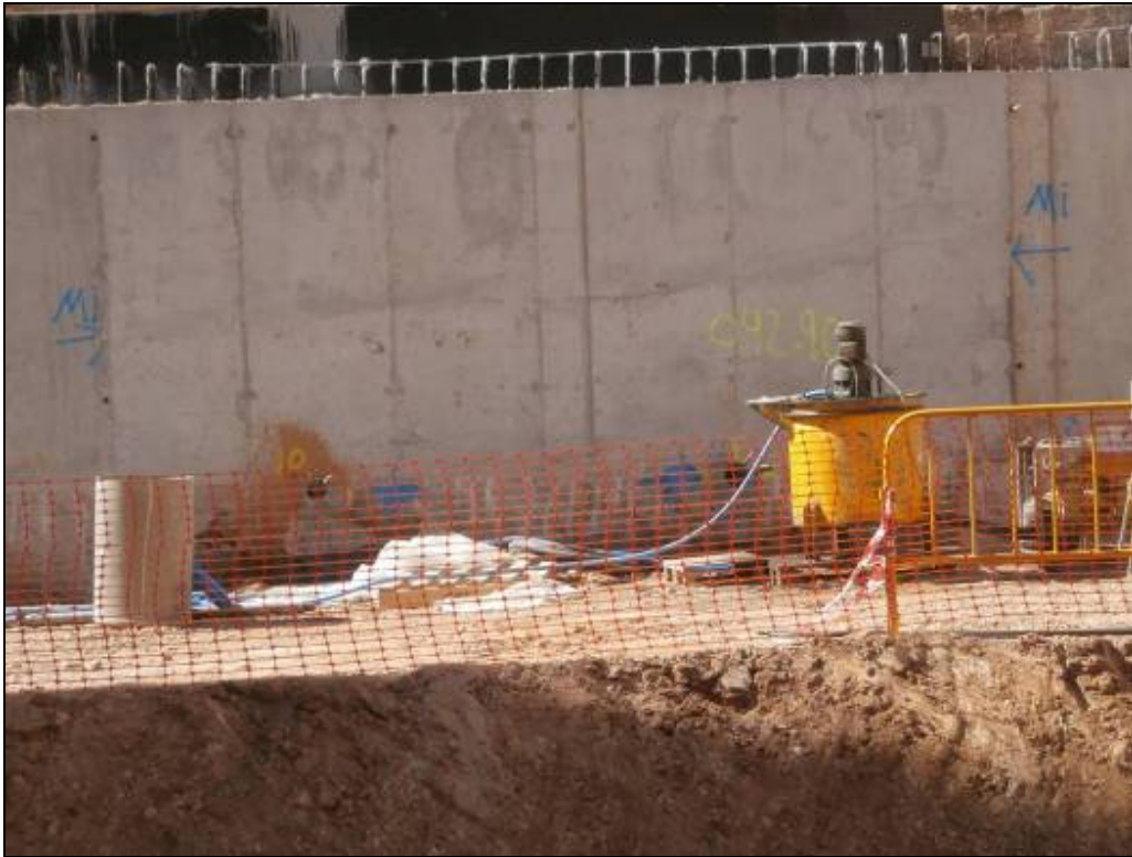
Fotografia 11: Senyalització del traçat de la mina a la pantalla de formigó del costat NO.
