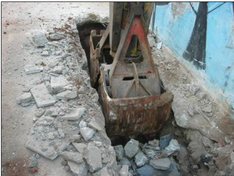
Fotografia 2: Procés d'excavació del sondeig de l'extrem NO del solar.
