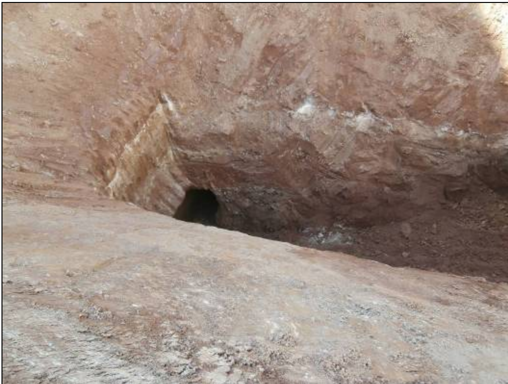
Fotografia 16: Despreniment de la volta i paret de la galeria de la mina.
