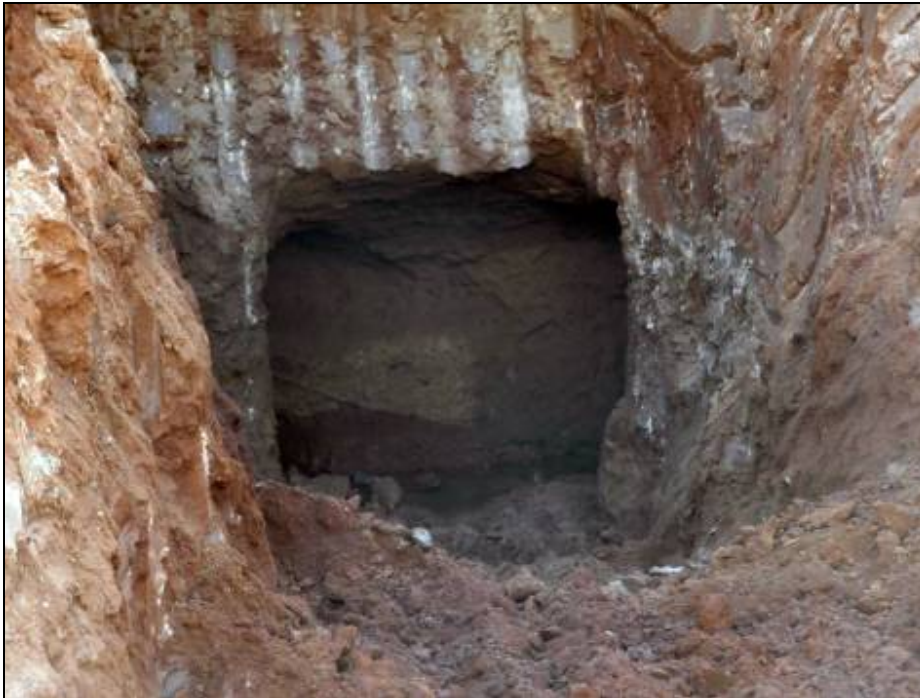
Fotografia 19: Detall de l'accés a la galeria de la mina.
