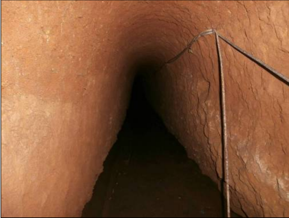
Fotografia 21: Tram de galeria vista en direcció SE, amb els cables caiguts.
