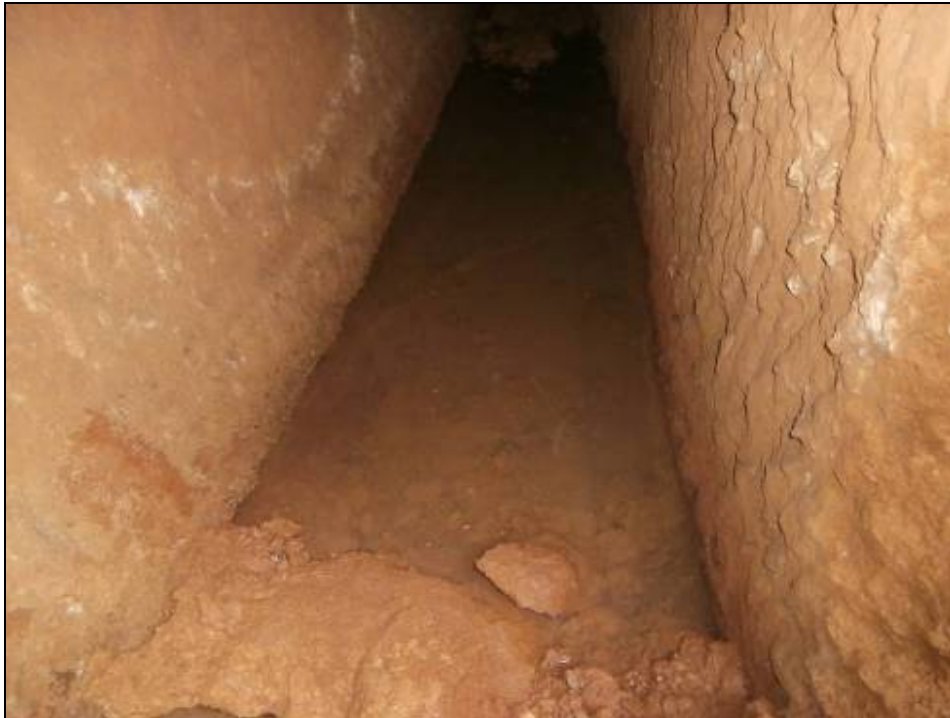
Fotografia 23: Aigua acumulada a l'entrada de la mina per la terra caiguda.
