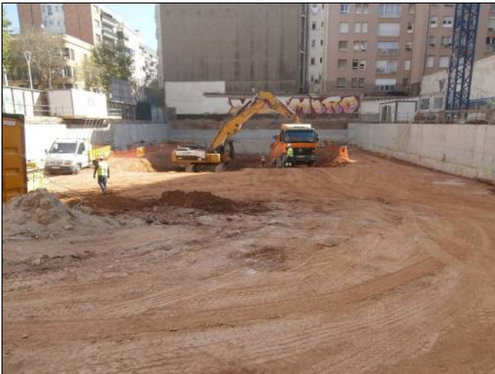
Fotografia 8: Vista general del solar durant els treballs de rebaix general.
