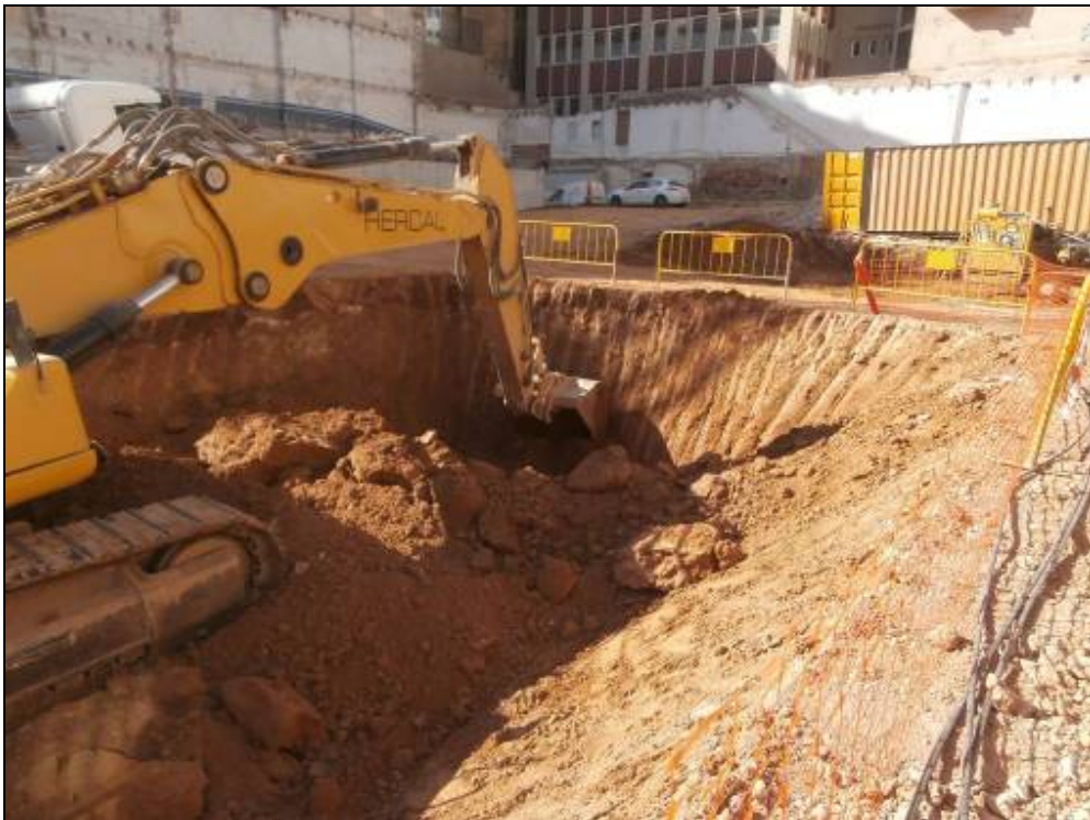
Fotografia 10: Rebaix a l'entorn de la ubicació de la mina.
