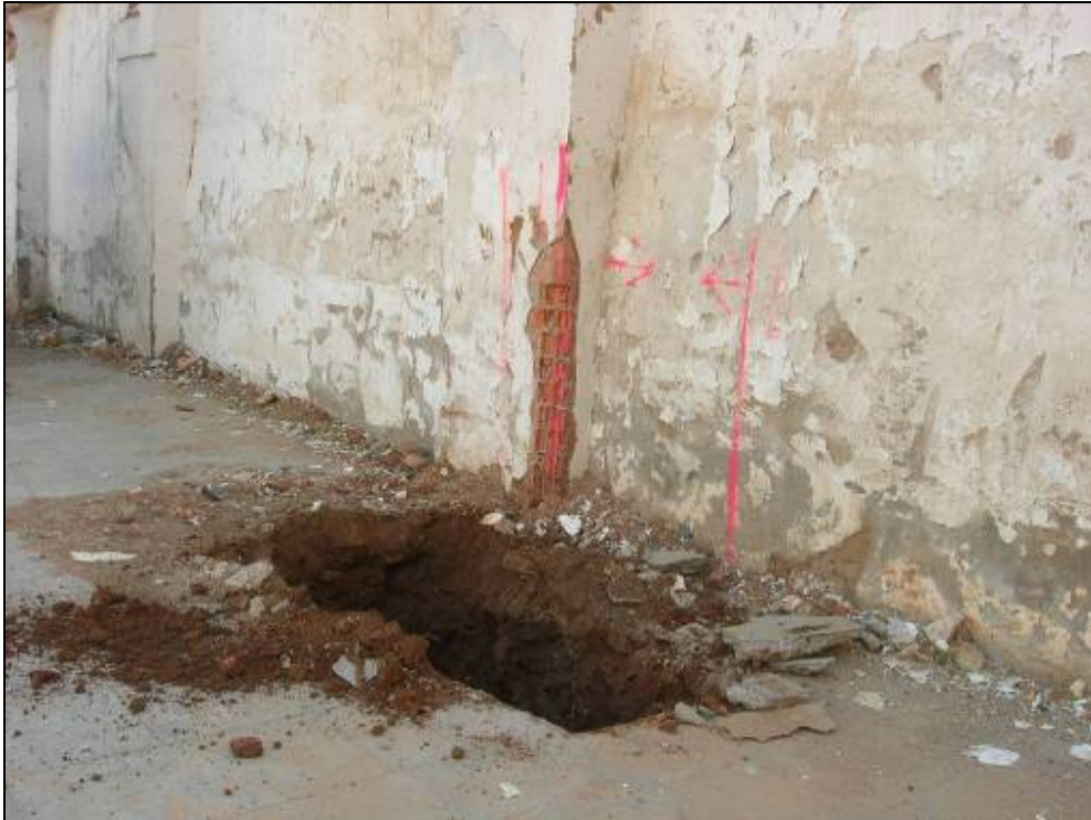
Fotografia 7: Senyalització exterior de la ubicació de la mina durant el sondeig.
